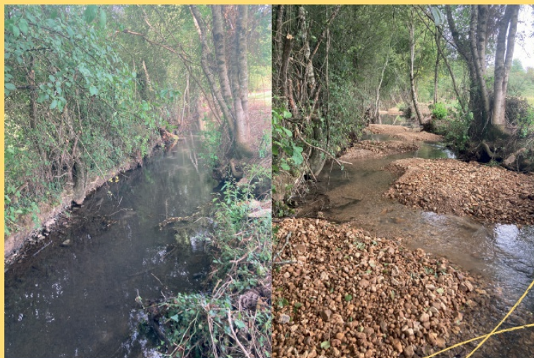
avant/après travaux sur le Bouzanteuil
